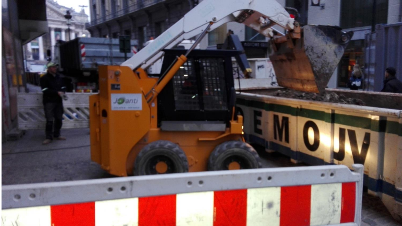
Photo 10 : Chargement des terres excavées
