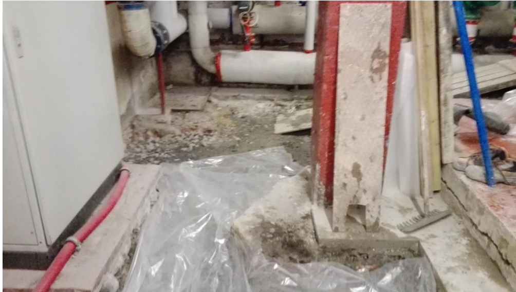
Photos 13 et 14 : Pose du deuxième film étanche sur les terres d'apports et des armatures dans le local chaufferie
