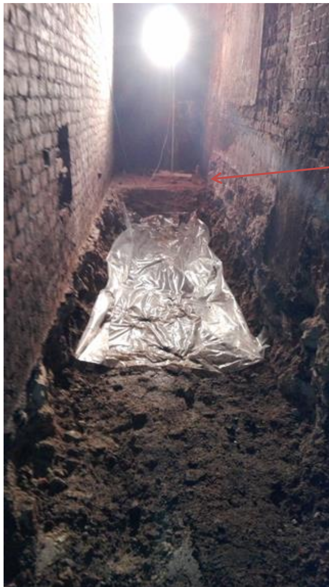
Photos 6 et 7 : excavation totale du local citerne et pose du film étanche en fond de fouille
