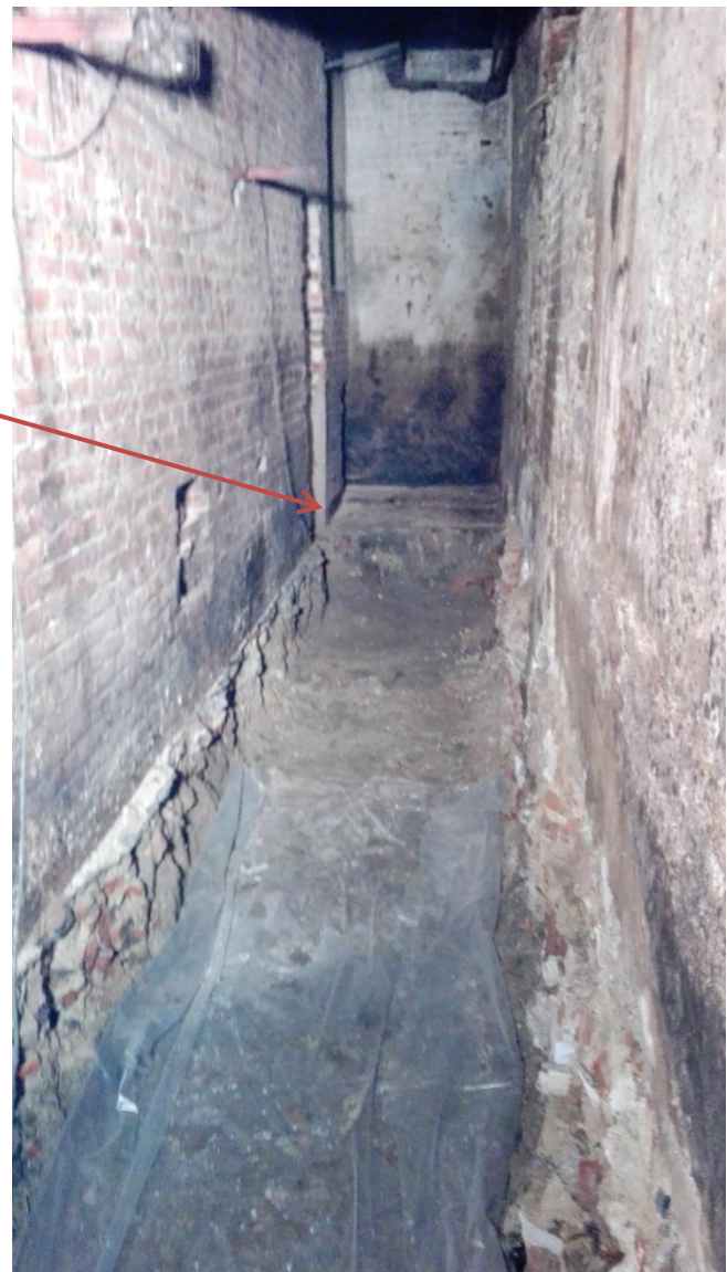
Photos 6 et 7 : excavation totale du local citerne et pose du film étanche en fond de fouille
