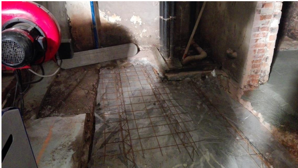
Photos 13 et 14 : Pose du deuxième film étanche sur les terres d'apports et des armatures dans le local chaufferie
