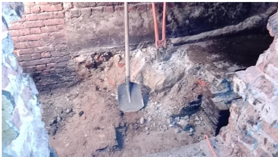
Photo 3 : Démolition des éléments de maçonnerie contenus dans le local citerne
