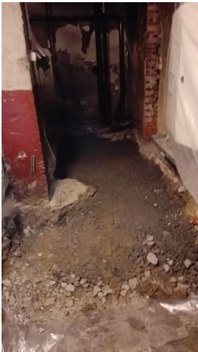
Photo 11 : Première partie du local chaufferie remblayée
