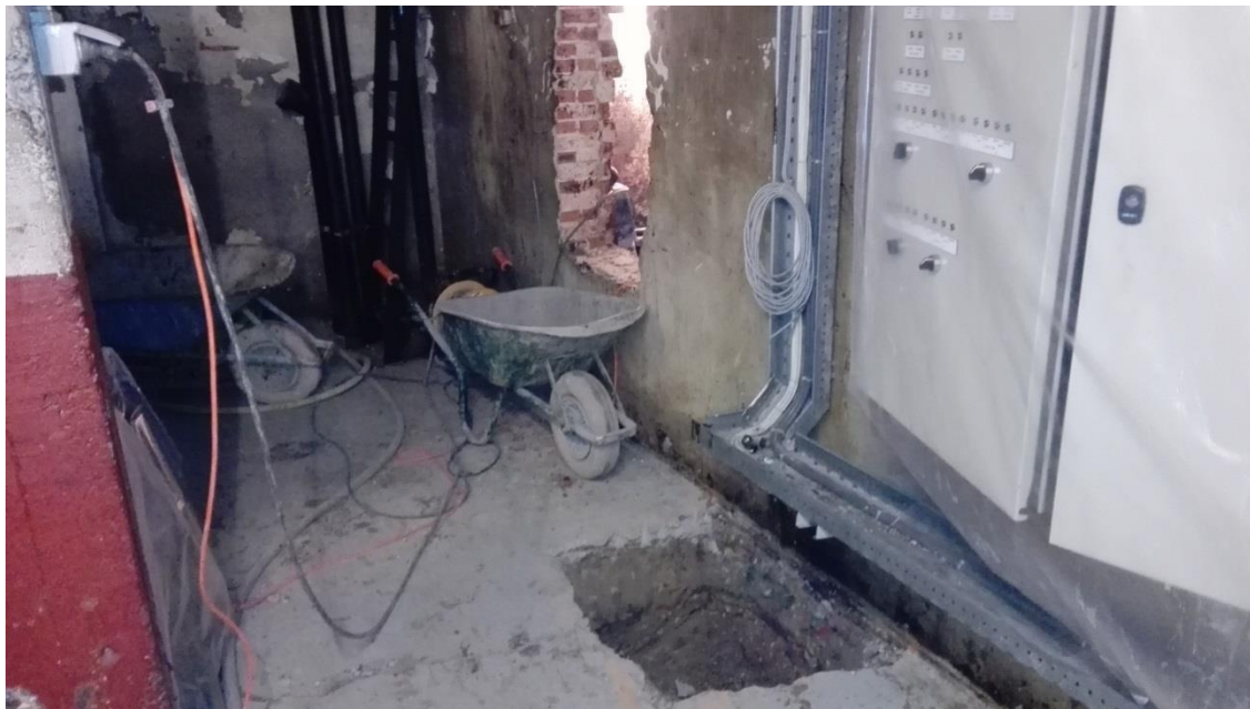
Photo 2 : Ouverture de chantier, prise de vue d'un essai pour la validation de la profondeur dans le local chaufferie
