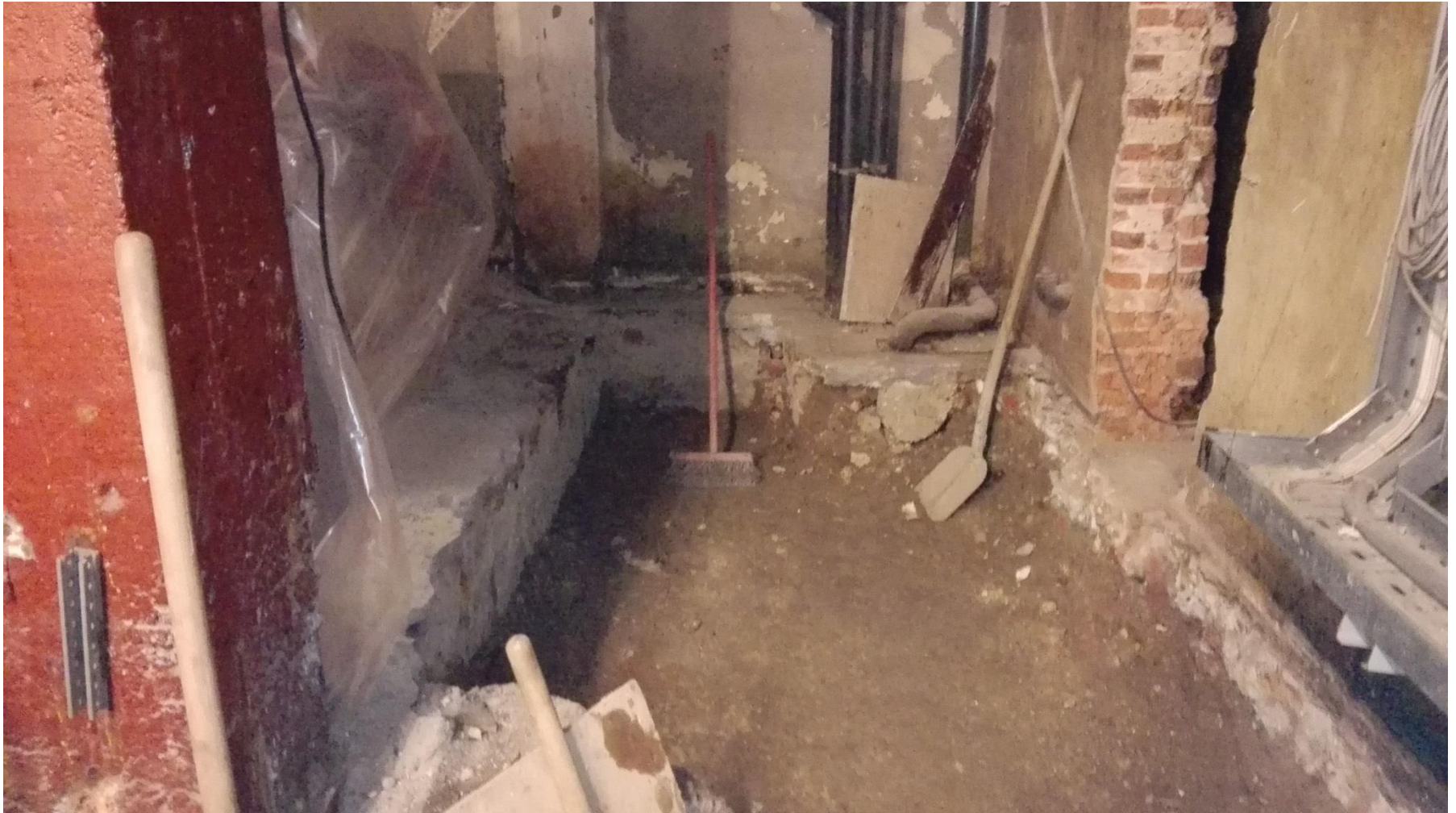
Photo 9 : Excavation de la première partie du local chaufferie
