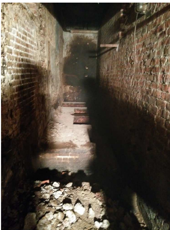
Photographie 2 : ancien emplacement cuve à excaver en deux phases
