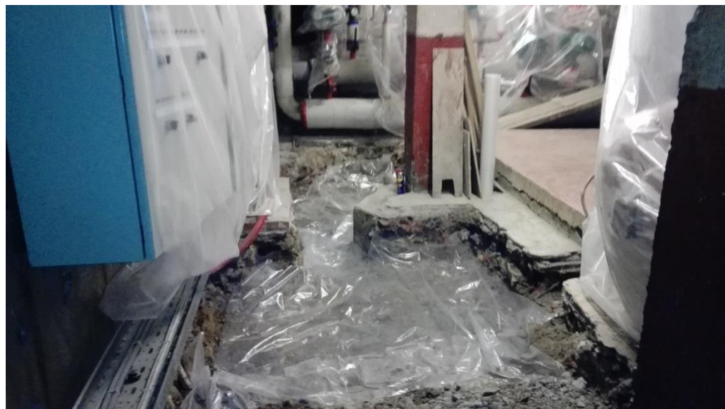
Photo 12 : Deuxième partie du local chaufferie excavée
