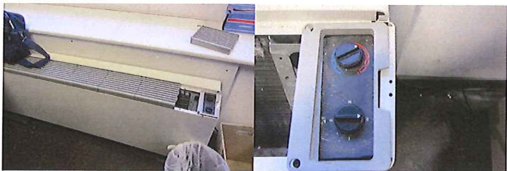
Figure 24 : Ventilo-convecteur et vanne thermostatique (7 ème étage).
