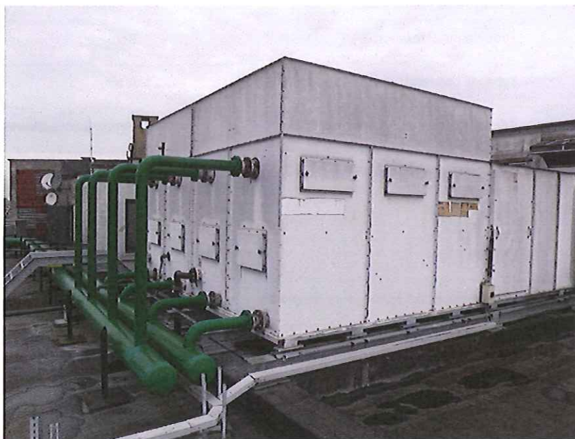
Figure 33 : Tour de refroidissement sur la toiture.
