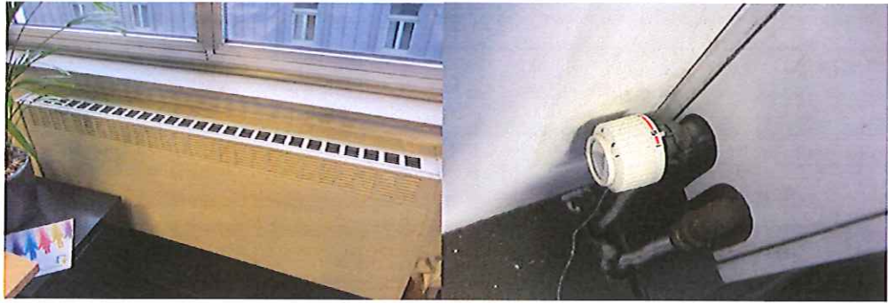
Figure 23 : Radiateur et vanne thermostatique.
